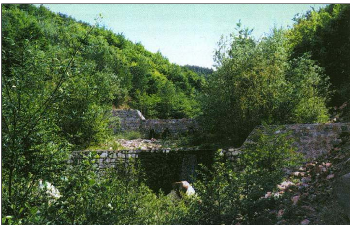
Фигура 10. Част от системата за укрепяване на „Лебедски дол“ – изглед от района преди (горе) и след (долу) противоерозионните мероприятия
