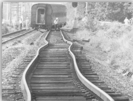
Фигура 10.5. Последници от действието на температурни напрежения ( http://www.businessinsider.com/why-train-tracks-buckle-in-extreme-heat-2013-7 )
