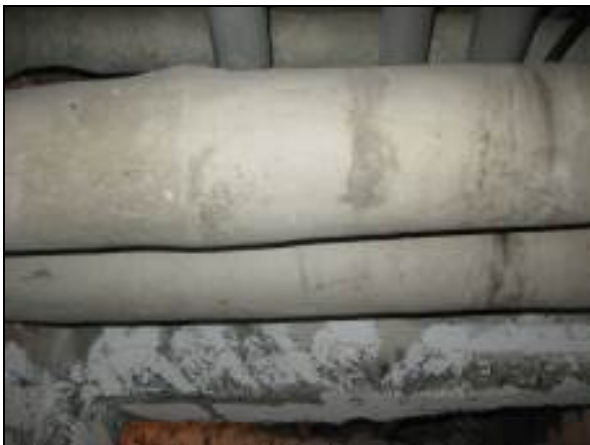
фиг.1.24 Разпределителна мрежа ВОИ
