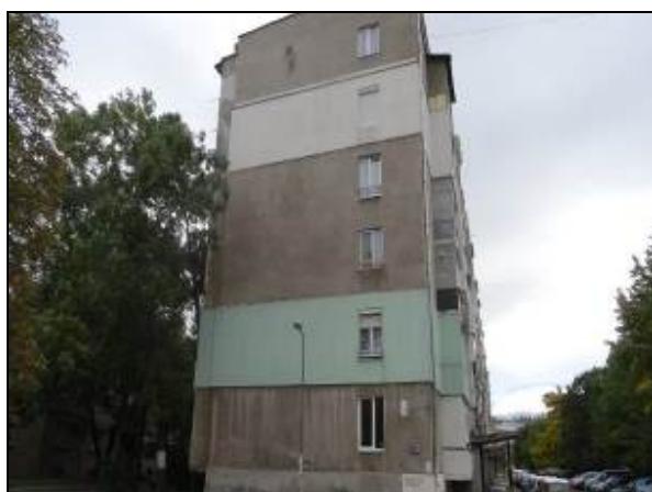
Фиг.1.2 Североизточна фасада
