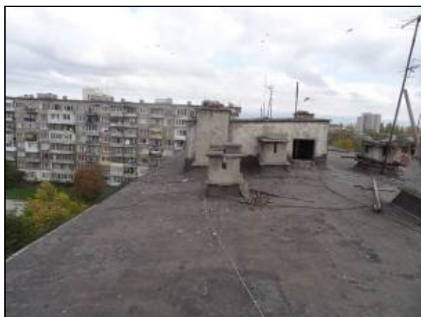
фиг. 1.14 Плосък студен покрив
