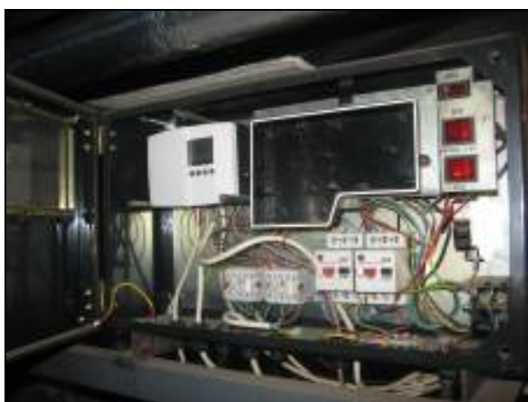
Фиг.1.21 Табло с „IP“ регулатор
