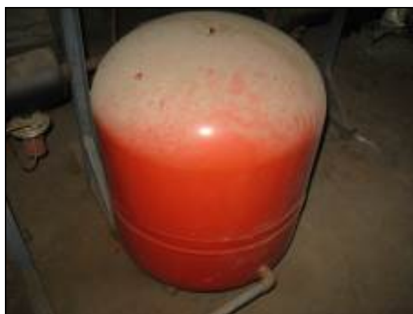
Фиг. 1.23 Затворен разширителен съд
