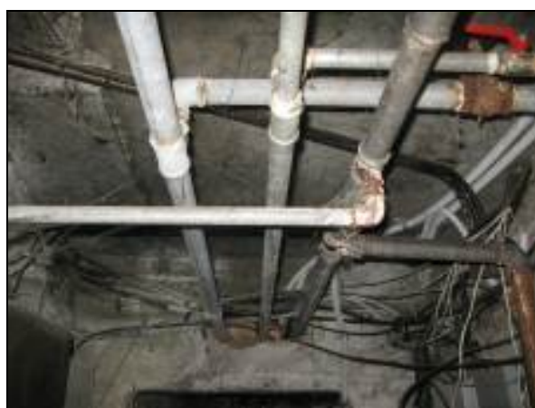
Фиг.1.30 Хоризонтална тръбна мрежа за БГВ, входове „А“ и „Б“
