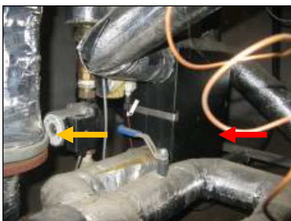
Фиг.1.29 Топлообменник с ЦП за БГВ
