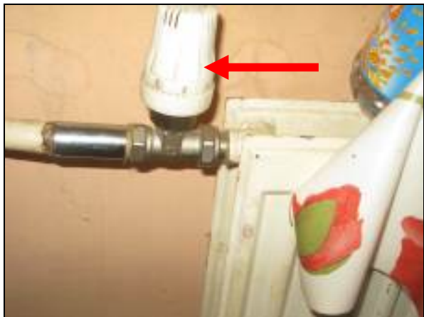
Фиг. 1.25 Панелен радиатор с термостатичен вентил
