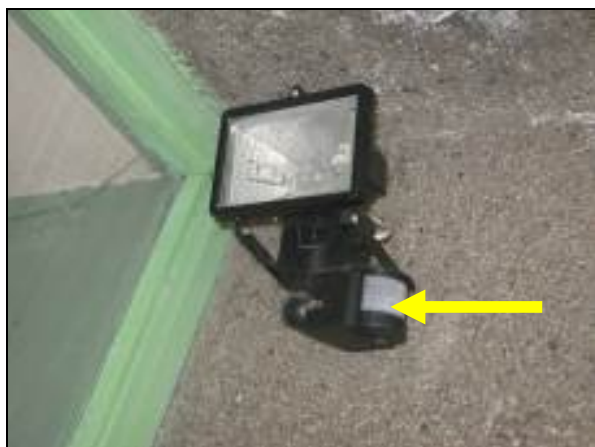
а/ автоматично с PIR датчици
