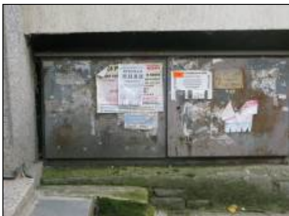
Фиг.1.33 Разпределителна касета НН
