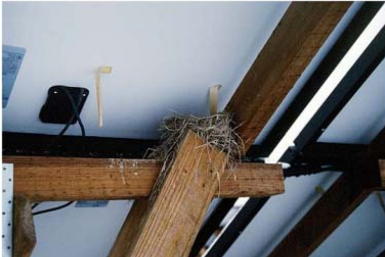
Фиг. 13: Гнезда под модулните плоскости.
