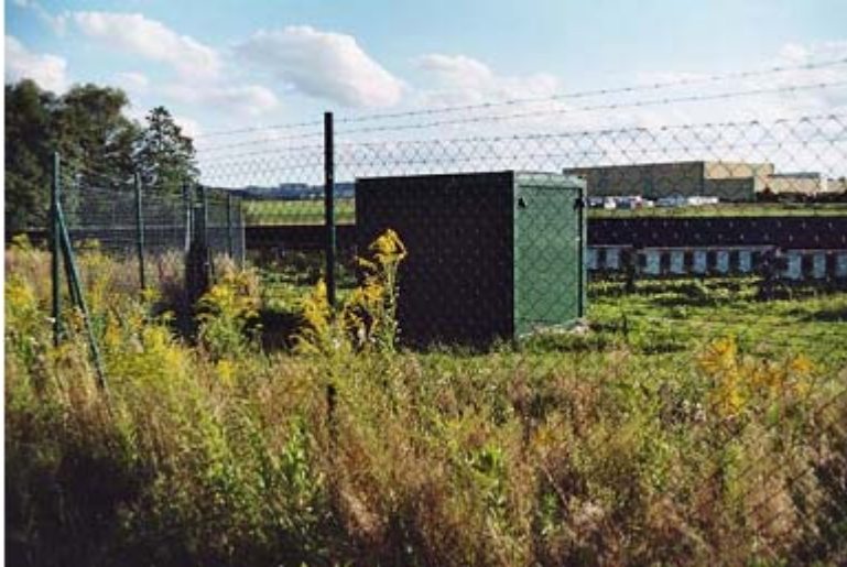
Фиг. 5: Пример за ограждане на ФВСОП.
