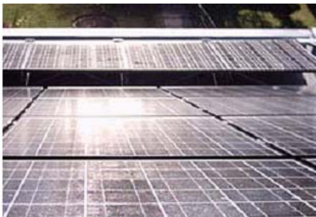
Фиг. 7: Пример за светлинно отражение на модулните повърхности. Източник: Internetfoto http://www.landmark-halle.de/img/jepgs/bild4.jpg
