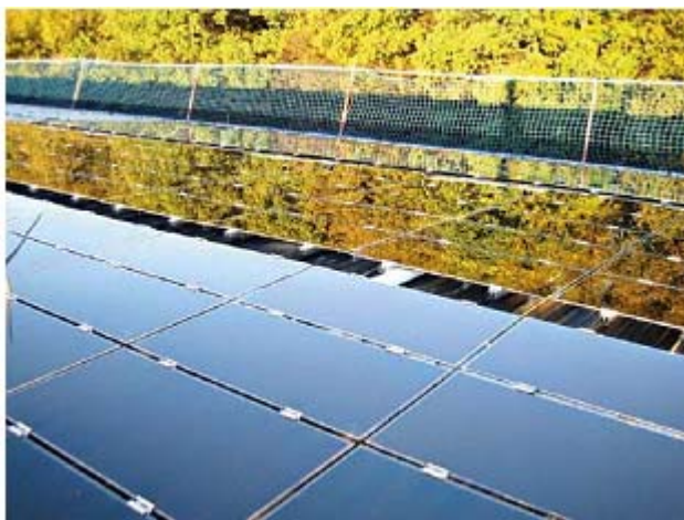
Фиг. 9: Пример за огледален ефект на модулните повърхности
